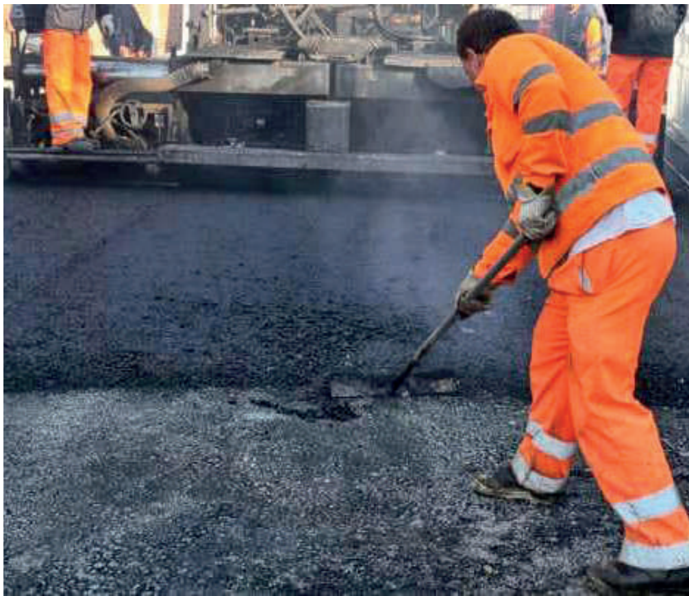
Operai del Comune asfaltano il corso Vittorio Emanuele
